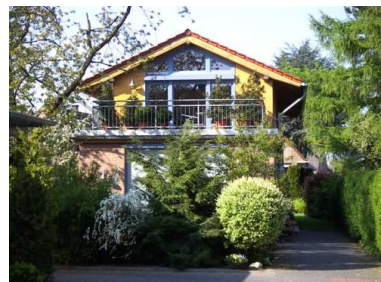
"Wasser" in den Fenstern Haus Ballhausen
